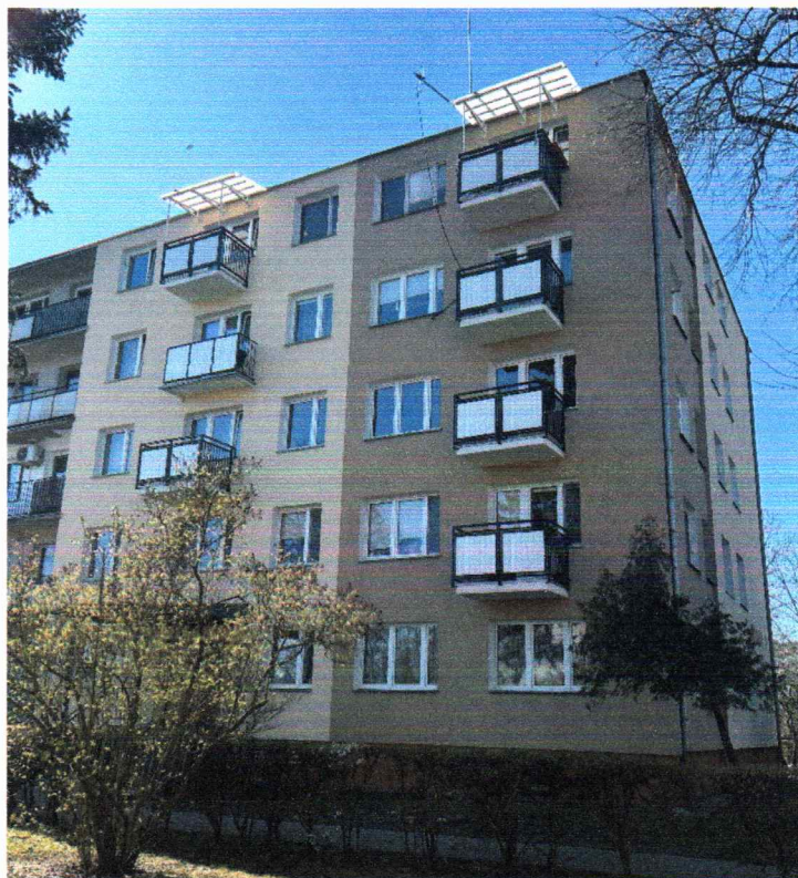
2. Remont balkonów w budynku przy ul. Bolesława Chrobrego 10
