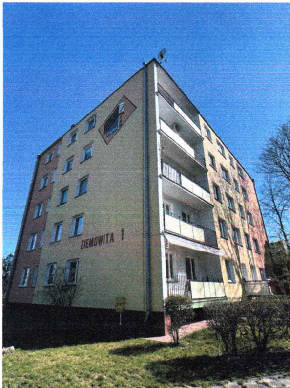
1. Malowanie elewacji budynku przy ul. Ziemowita 1
